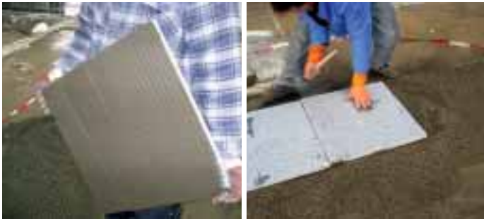
Die aufgebrachte Haftbrücke und das Einklopfen der Platte in das frisch aufgezugene Mörtelbett.
