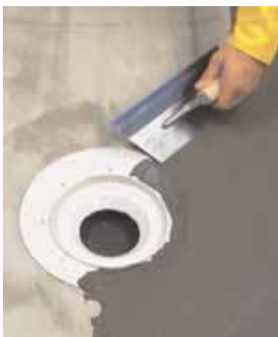
Bodeneinlauf mit Superflex D2 für Wohnungsbäder mit Bodenablauf (Beanspruchungsklassen A02), Balkone (B0), hoch belastete Bodenbereiche (A2), Schwimmbecken (B, Bodenabläufe im Schwimmbecken nur als Los/Festflanschkonstruktion!)
