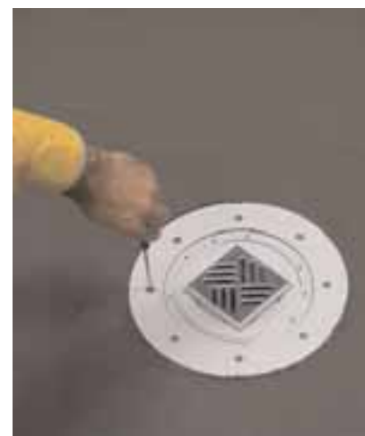
Bodeneinlauf mit Superflex D2 für Wohnungsbäder mit Bodenablauf (Beanspruchungsklassen A02), Balkone (B0), hoch belastete Bodenbereiche (A2), Schwimmbecken (B, Bodenabläufe im Schwimmbecken nur als Los/Festflanschkonstruktion!)
