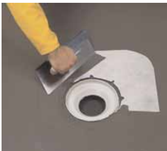
Bodeneinlauf mit Superflex D2 für Wohnungsbäder mit Bodenablauf (Beanspruchungsklassen A02), Balkone (B0), hoch belastete Bodenbereiche (A2), Schwimmbecken (B, Bodenabläufe im Schwimmbecken nur als Los/Festflanschkonstruktion!)
