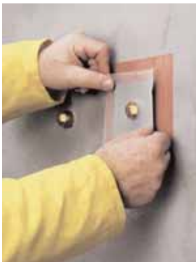
Dicht- und Klebesysteme für Wohnbäder mit (Beanspruchungsklasse 0) und ohne Bodenablauf (A01 und A02) sowie für hoch belastete Wandbereiche (A1)
