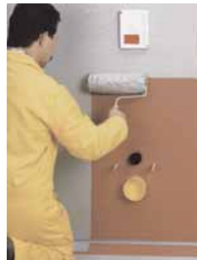
Dicht- und Klebesysteme für Wohnbäder mit (Beanspruchungsklasse 0) und ohne Bodenablauf (A01 und A02) sowie für hoch belastete Wandbereiche (A1)
