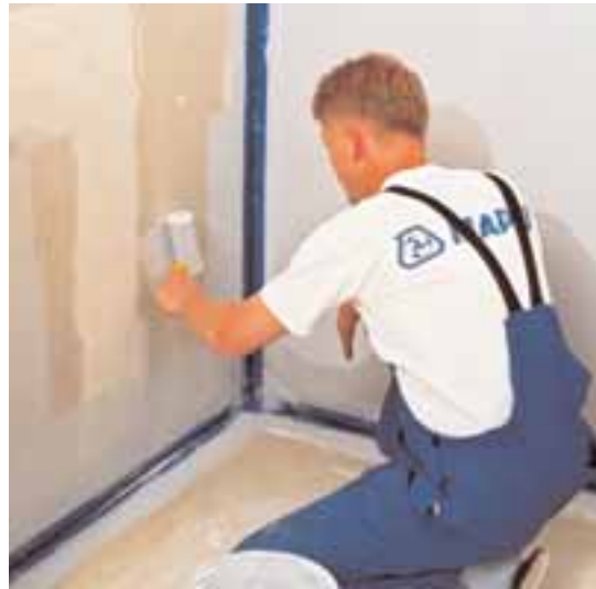
Auftrag von Mapegum WPS
