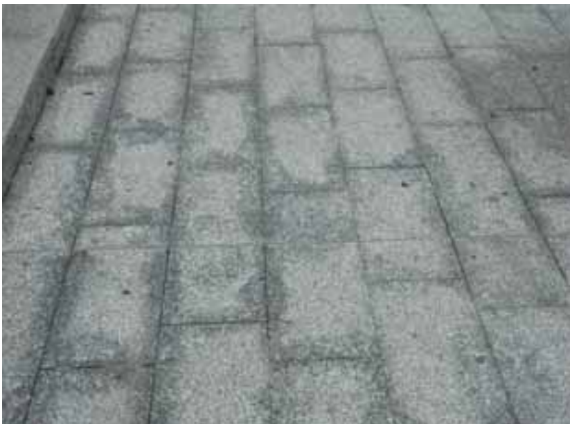
Nahezu dauerhafte Feuchtflecken auf ROSA BETA: Der relativ feinkörnige Verlegemörtel (nach DIN 18332) ist nass; entsprechend verfleckt der saugfähige Granit.
