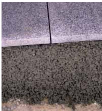
3 cm dicker Granit mit 15 cm dickem Monokornmörtel
