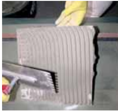
Aufgetragene Kleberschicht
