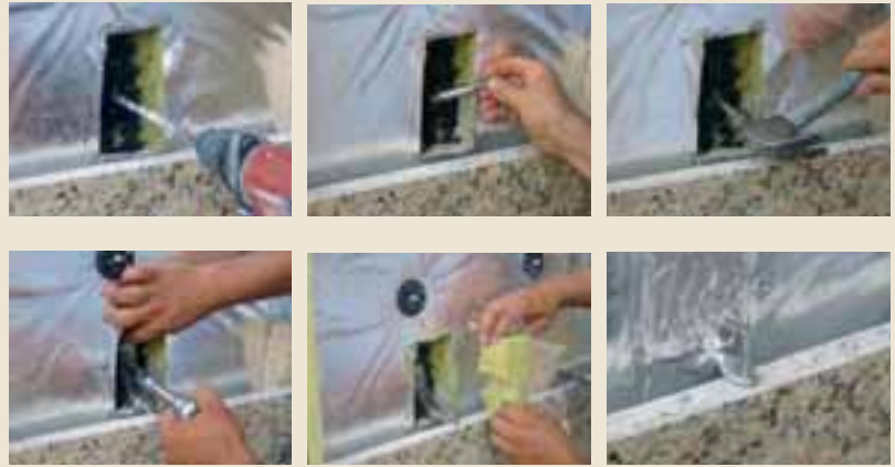
Befestigung von Fassadenplatten mittels Body-Ankern zum Andübeln
